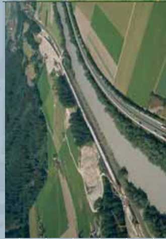
Abb. 2: Luftbild der Hauptbaumaßnahmen H6 Galerie Terfens mit bereits fertiggestellten Blöcken, sowie fertig gestellter Grünbrücke (Stand: Sommer 2006).
