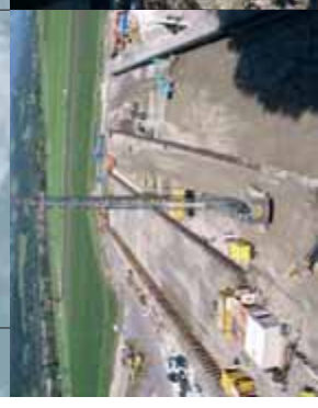
Abb. 2: Baugrubenverbau mit Totmannverankerung
