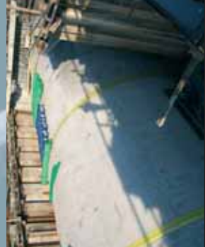
Abb. 7: Abdichtung des Tunnelgewölbes
