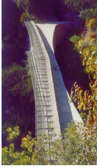
Erhaltungszustand der alten Brücke Stato di conservazione del vecchio ponte
