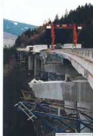
Bild 6: Montage der Aussentragwerke.
