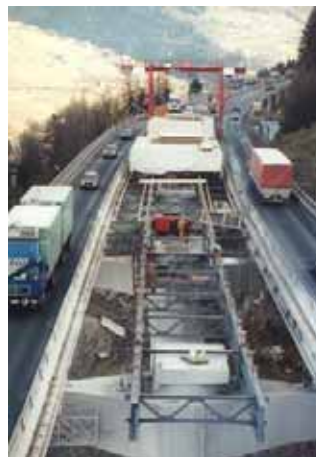
Bild 7: Betonieren der Innentragwerke
