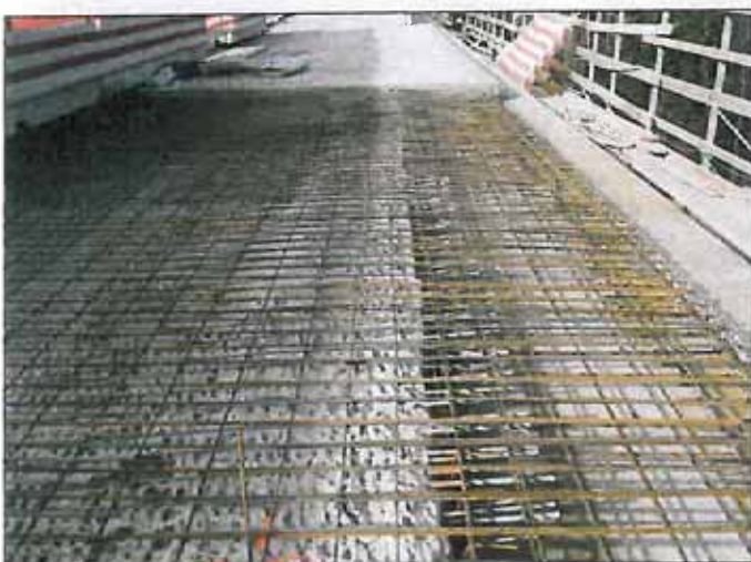
Figura 12 - L'allargamento della soletta
