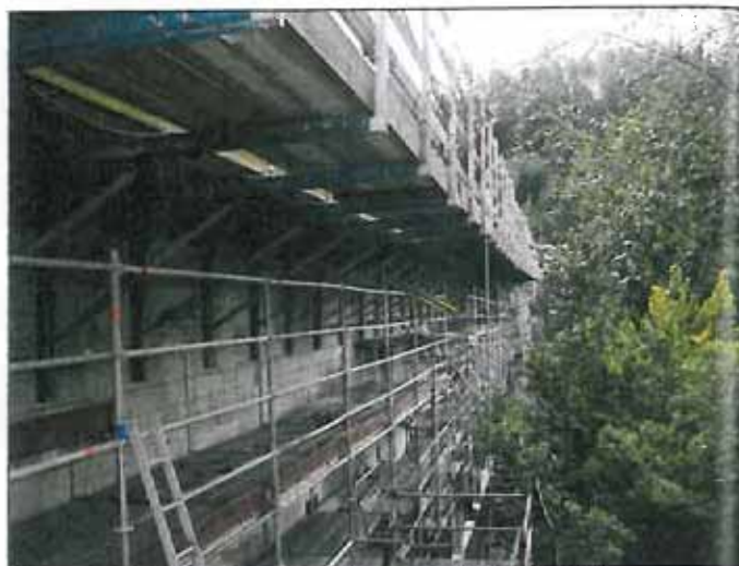
Figura 13 - Il cassero e il piano di lavoro per l'allargamento
