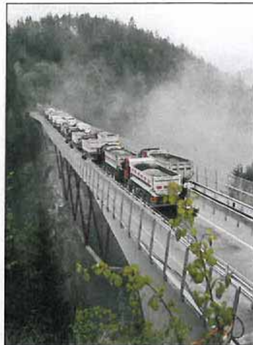
Figura 16 - La prova di carico
