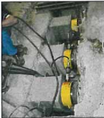
Figura 9 - Il posizionamento dei martinetti idraulici in chiave
