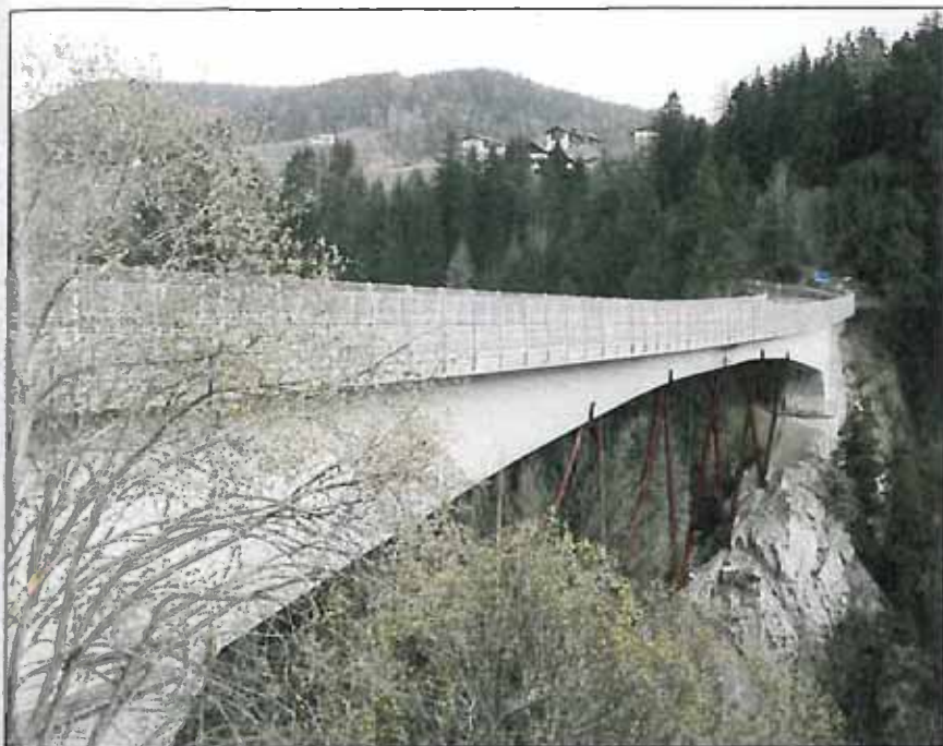
Figura 15 - Il ponte ristrutturato
