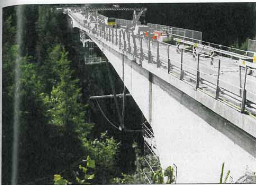
Figura 7 - Il montaggio dei puntoni in acciaio a V per la sospensione
