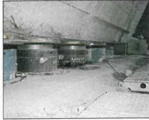
Figura 10 - La sostituzione degli apparecchi di appoggio
