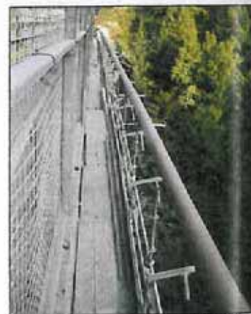
Figura 14 - Gli spostamenti provvisori delle infrastrutture presenti sul ponte
