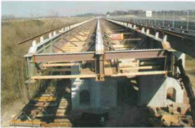
Bild 10. Stahltragwerk beim Einschub Fig. 10. Steel structure during launching
