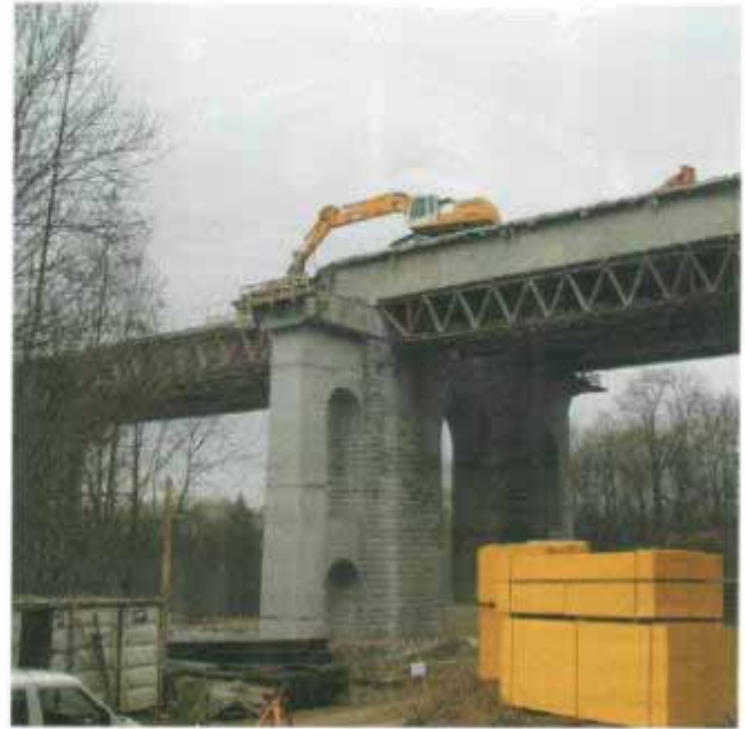
Bild 12. Abbruch der Spannbetontragwerke Fig. 12. Demolition of the prestressed superstructures
